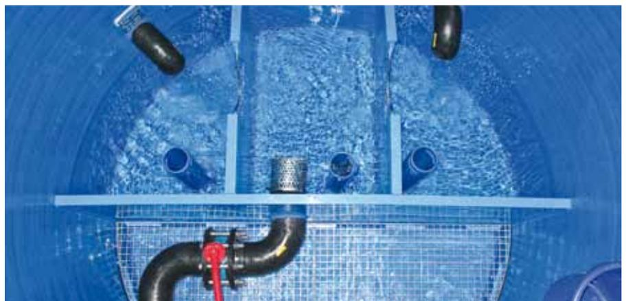
FTW®-Quellsammelschacht DN 1500 mit Zu- und Ablauf, inkl. Seiher und Absperrklappe
