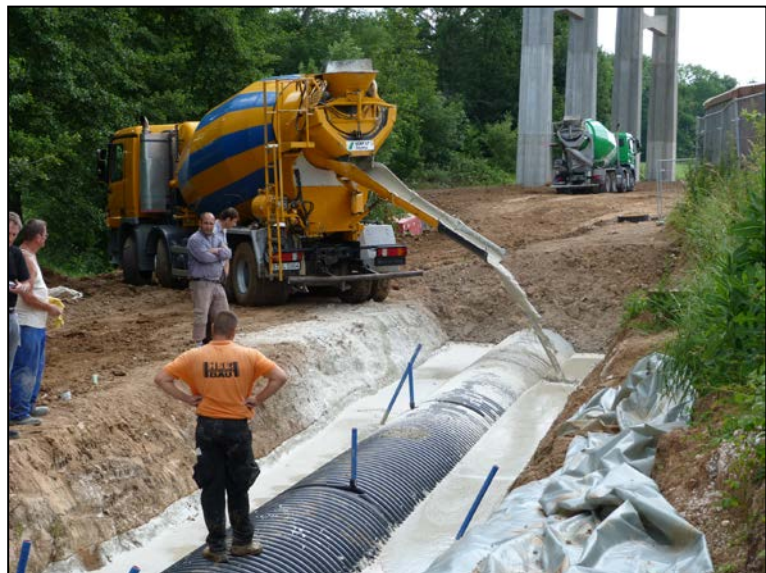
Abb. 7: Einbringen des thermisch optimiertem Verfüllbaustoffes
