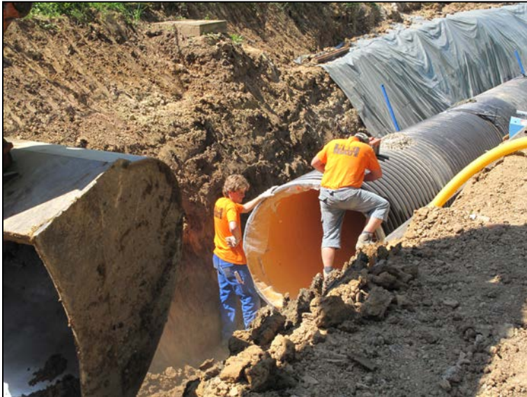
Abb. 6: Grabenaushub/Rohrleitungsbau - Herstellen der PKS-Thermpipe®-Anschlüsse
