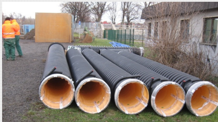
Abb. 1: Lagerung der PKS-THERMPIPE-Rohre DN 500, 6 m Baulänge auf der Baustelle
