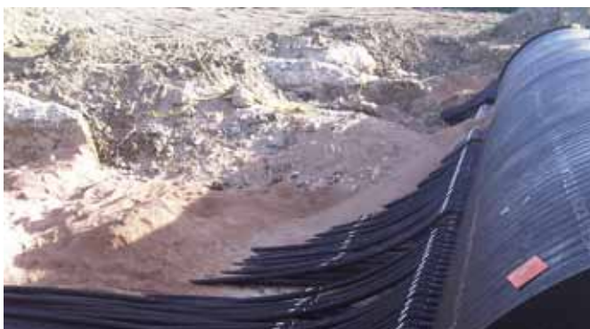
Anbindeleitung am Verteilerschacht in horizontaler Bauweise
