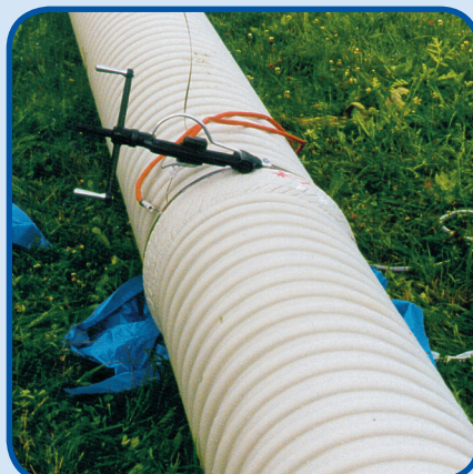
Angeformte Elektroschweißmuffe
