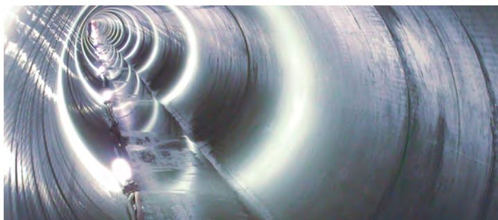
Auskleidung von Abwasserstollen – Ein mit PE-Betonschutzplatten dauerhaft dicht ausgekleideter Stollen mit einer Gesamtlänge von 2700 m.
