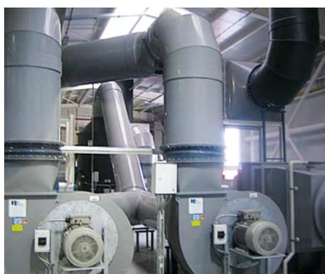
Lüftungsleitung aus PPs – Schwerentflammbare Lüftungsleitungen entsprechen der Baustoffgruppe B1 nach DIN 4102.
