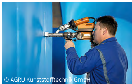
Komplexe Bauformen lassen sich einfach mit Betonschutzplatten auskleiden und schweißen
