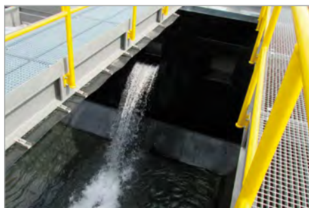
Beckenauskleidung mit Betonschutzplatten aus PE
