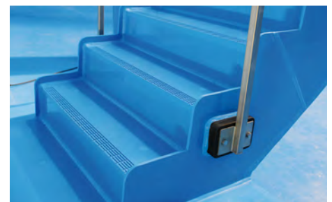
Auskleidung einer Betontreppe mit PE-Platten
