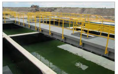
Beckenauskleidung mit Betonschutzplatten aus PE
