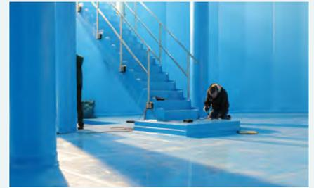
Nacher: Mit HydroClick ausgekleideter Trinkwasserspeicher
